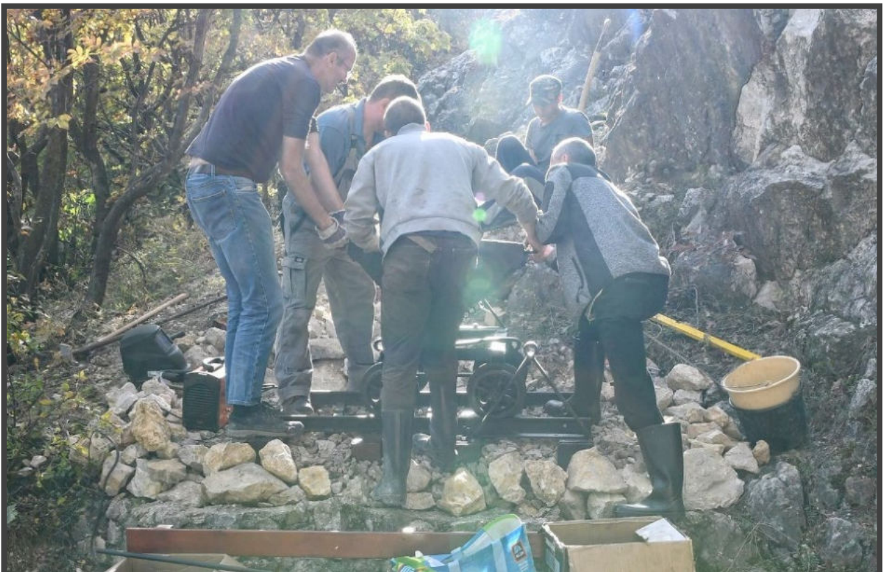
A csille összeszerelése, csavarkötések létrehozása.
