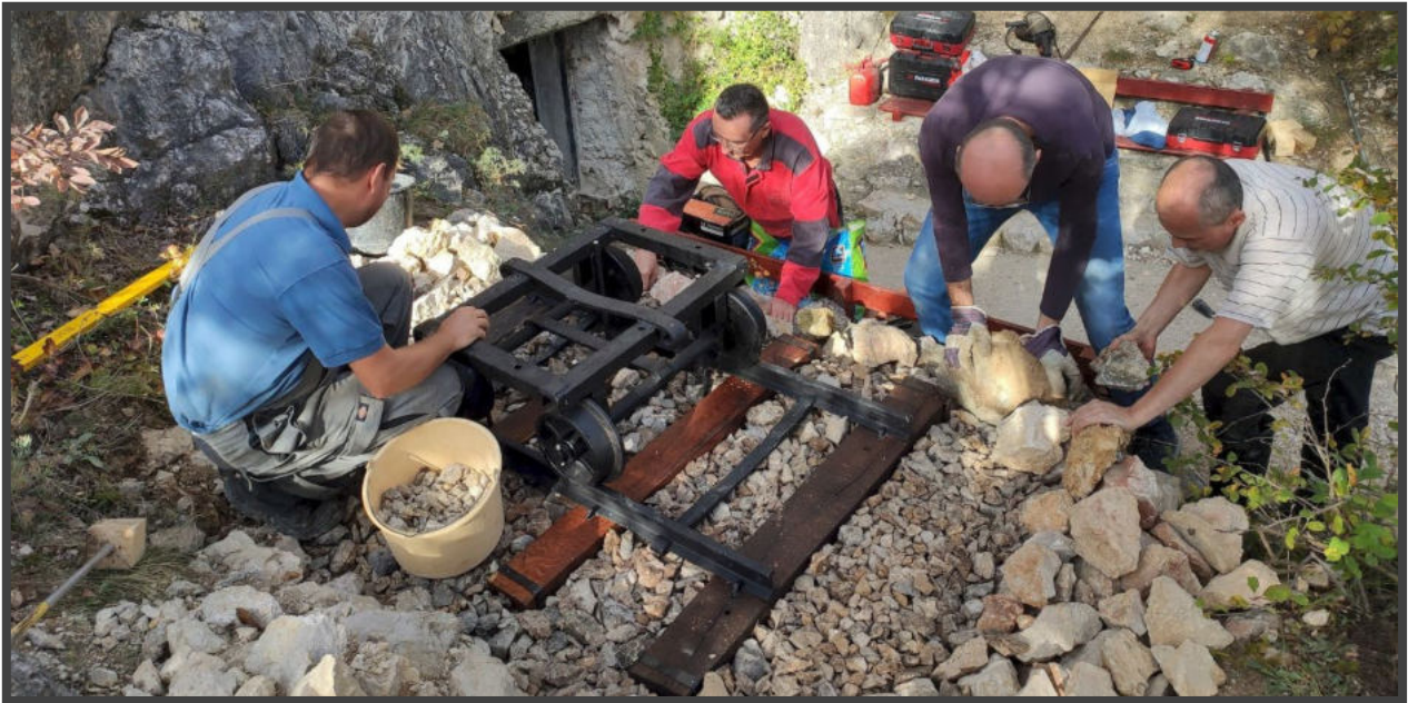
A csillealváz ráhelyezése a sínekre, a horgonyok közé, valamint a környezet rendezése.
