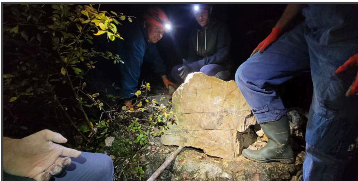
A szikla helyreigazítása kézi erővel, acélcsővek segítségével történt.
