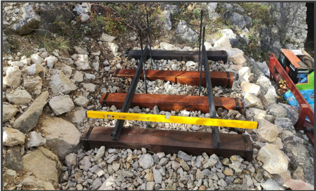
A talpfák fektetése és ellenőrzése vízmérték segítségével.
