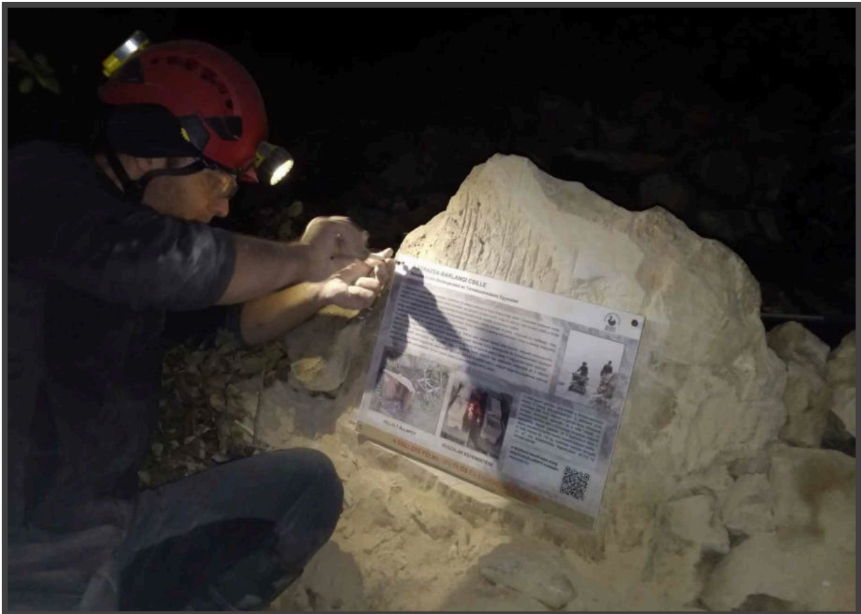
A tábla rögzítése Ø8 fischer dübelek segítségével.
